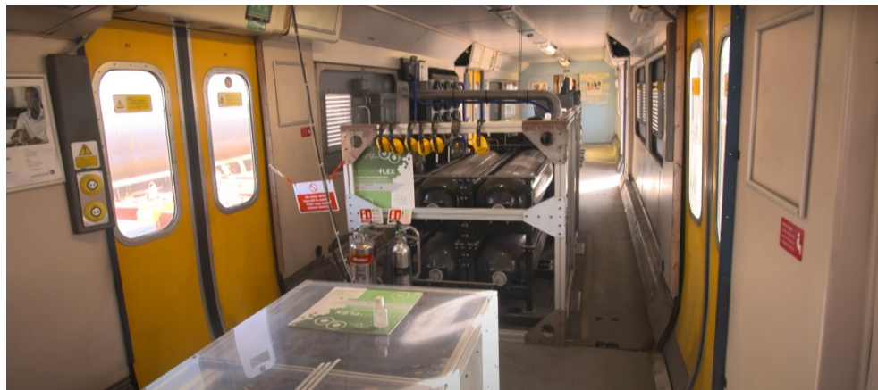
Rys. 3. Maszynownia brytyjskiego pociągu wodorowego
